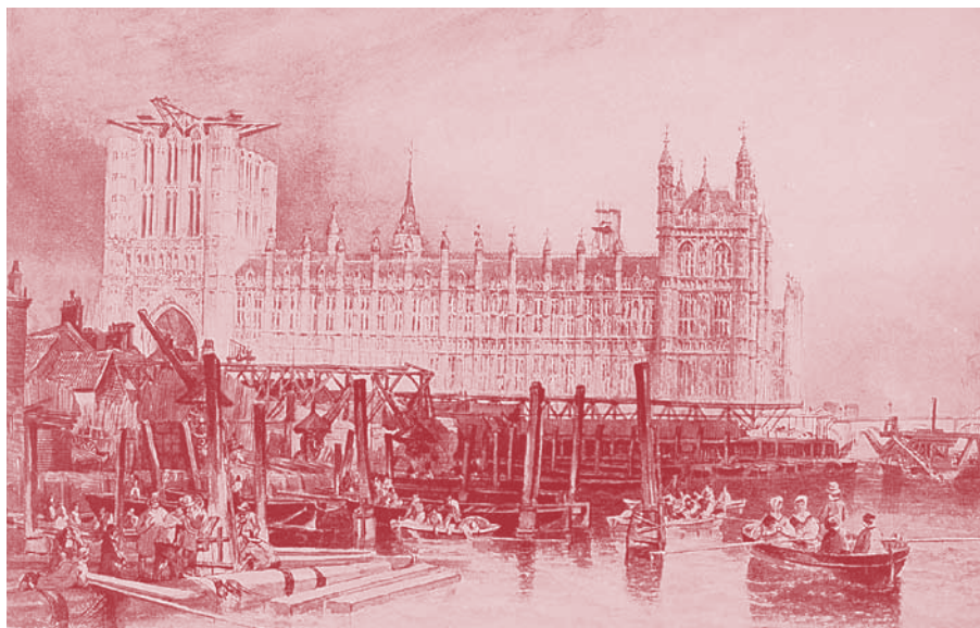
イギリス国会議事堂の工事風景（1855年 周囲に走行クレーンを配置し、塔建設に蒸気力クレーンを使用している）
